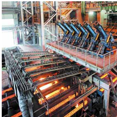
Мал. 63. Машина безперервного лиття заготівель конвертерного цеху ПАТ «АрселорМіттал Кривий Ріг»
