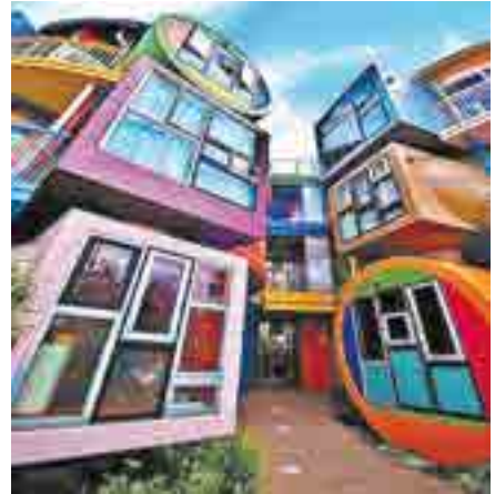
Фасад будинку в Токіо (Японія)
